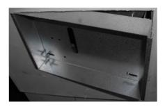
Jetzt kann zuerst die linke Seite hinter die Hohlwand gebracht werden. Anschließend den Kasten auch rechts flächenbündig einpassen. Danach den Haltebügel mit Hilfe der Schrauben wieder nach rechts rücken und und gleichmäßig (nicht zu fest) anziehen.
