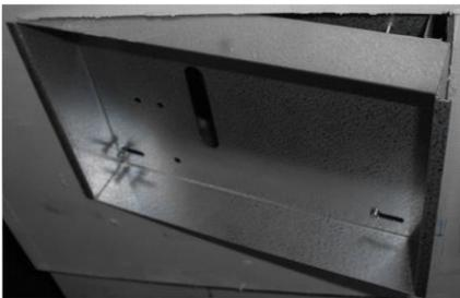
Jetzt kann zuerst die linke Seite hinter die Hohlwand gebracht werden. Anschließend den Kasten auch rechts flächenbündig einpassen. Danach den Haltebügel mit Hilfe der Schrauben wieder nach rechts rücken und gleichmäßig (nicht zu fest) anziehen.
